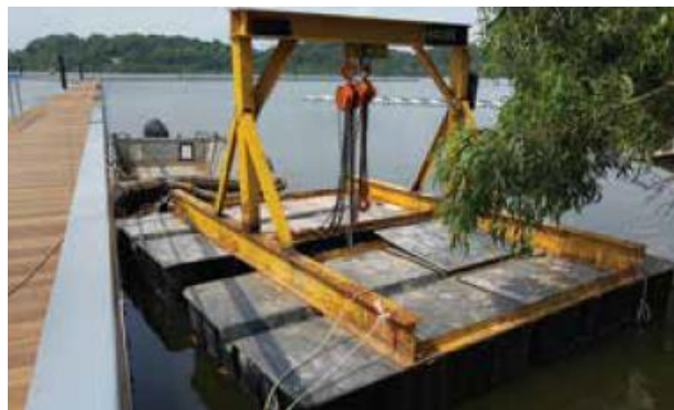
Figure 19: Petite barge d'installation (source: SERIS)
